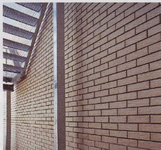
Siltinātās un ventilējamās fasādes apdarei izmantoti divi materiāli – kompozitmateriāla «Fundermax» plātnes trijos dažādos toņos un AS «Lode» apdāres ķieģeļi «Vecā Sarmite» smilšu krāsas tonī.
